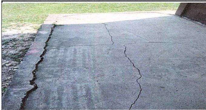
Foto 3: Se observa el deterio del piso del corredor del modulo 1.
