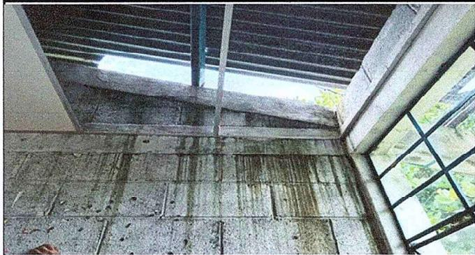
Foto 1: Se observa el deterioro de las costaneras y techo del modulo1.
