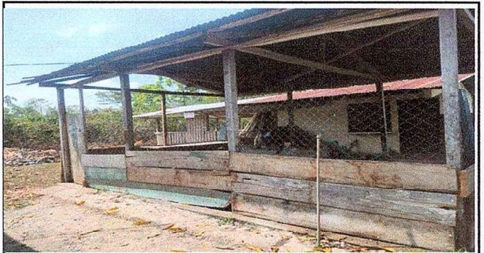
Foto 4: Se observa el deterioro de la pared de la cocina del modulo 2.
