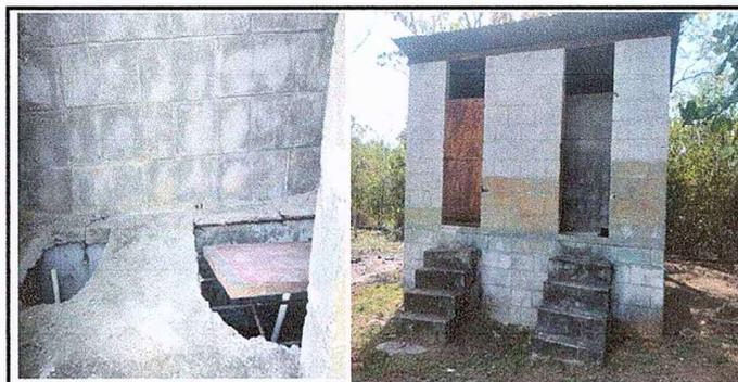
Foto 5: Se observa el deterioro de la planca y letrina pvc y la puerta del baño modulo3
